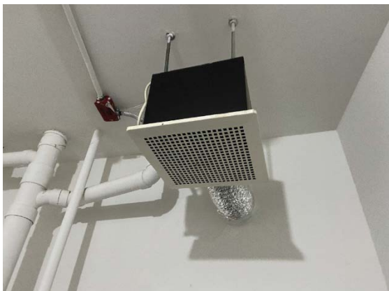
รูปที่ 3 ระบบระบายอากาศและช่องเปิดระบายอากาศ
